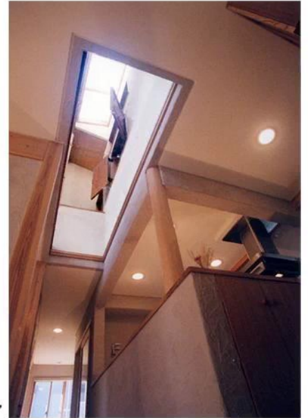
建物の中心であるキッチンシンク前のホールに自然光を導く
