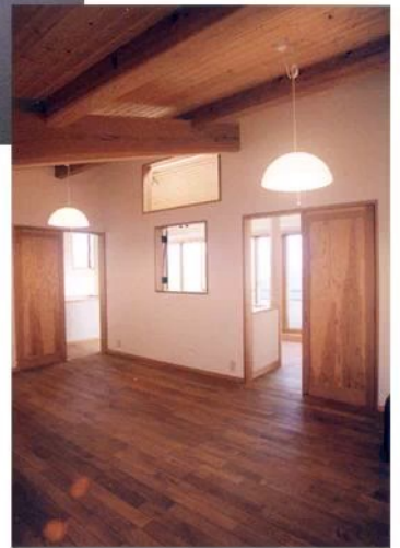
将来中央で間仕切り予定の子供室 トップライトの吹抜に面した 内窓と上部の開口は南の光の 取り入れ開口
