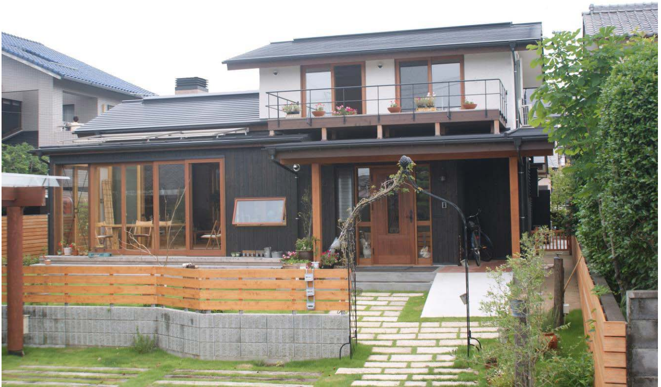
アプローチと南側外観
