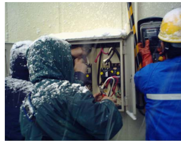
切替作業 電力会社によるメーター撤去
