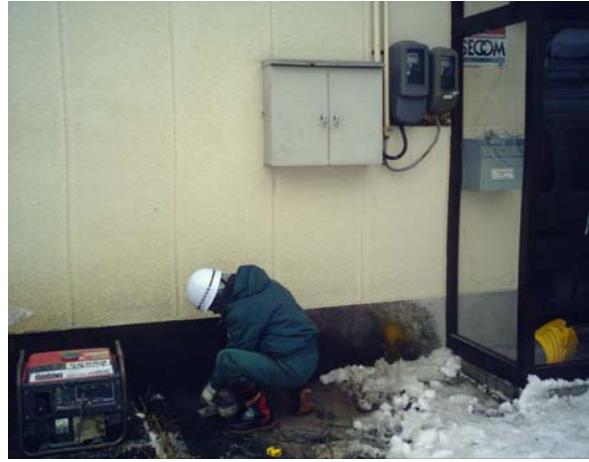
電柱を立てるため、 アスファルトを高速カッターで切断
