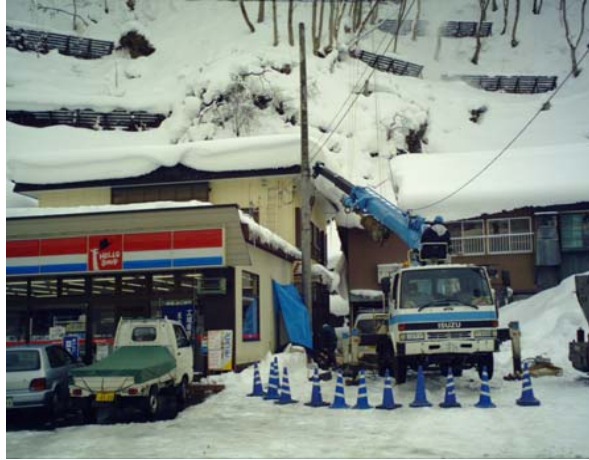
電柱を立てる
