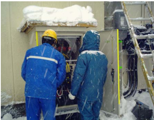
高圧受電設備に 電気を送る検査
