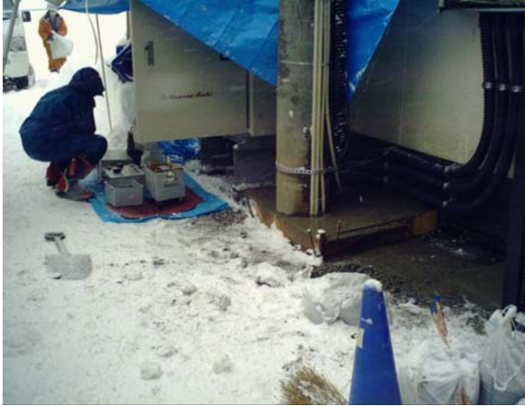
電気主任技術者による 耐压試験
