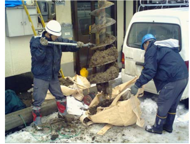
電柱を立てる穴を掘る
