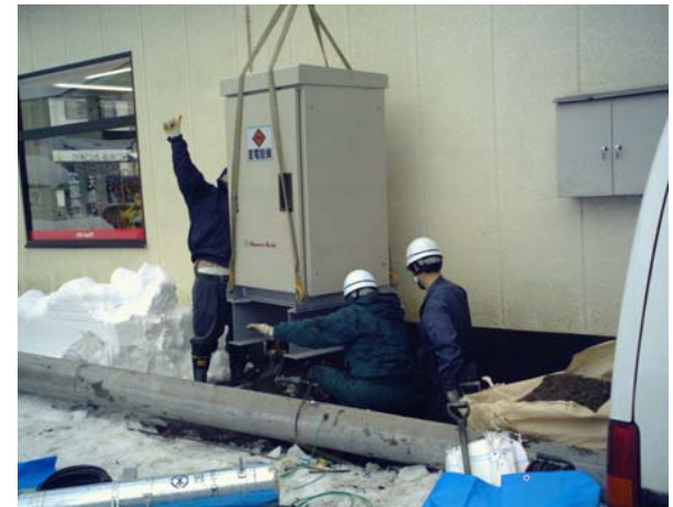
高圧受電設備の設置 (キュービクル)
