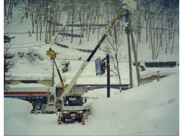
活線作業 高圧線 6600V 高圧線引込作業
