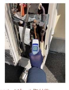
ソルベジェル取付後 冷媒配管A 低温低圧(液体):19.4℃ (-13.7℃)
