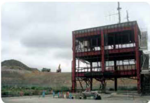
南三陸町 防災庁舎の周辺は一変していた
