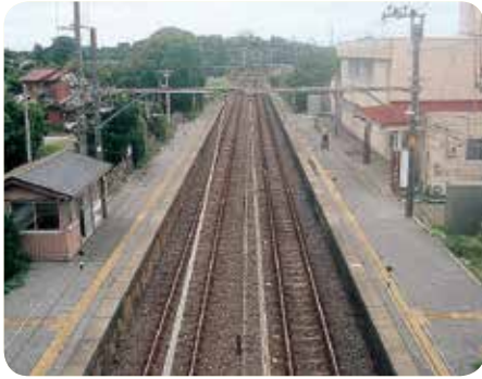
上りホームの一部屋根取り付け調査
