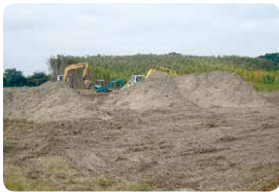
築山工事が始まった竜宮台地先
