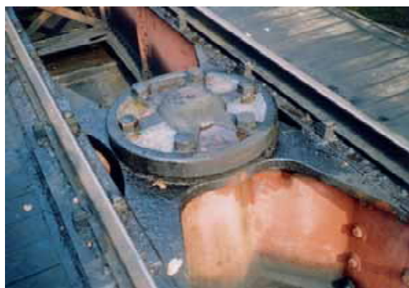
写真6 中央支承部外観
