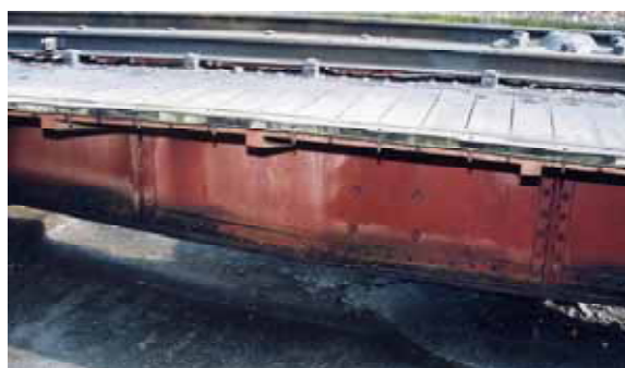
写真7 転車台の桁(側面から)
