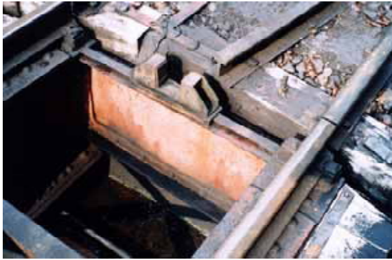
写真2 桁端のプレート
