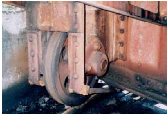
写真4 転車台の桁端車輪
