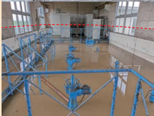
西通川揚水機場
