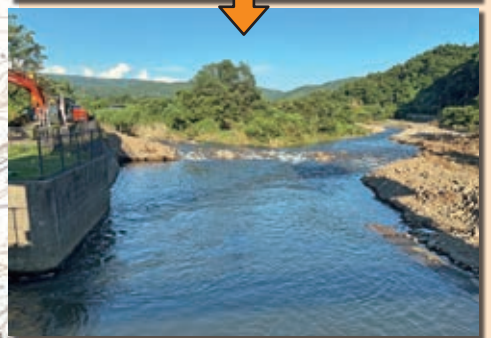
月光川頭首工
