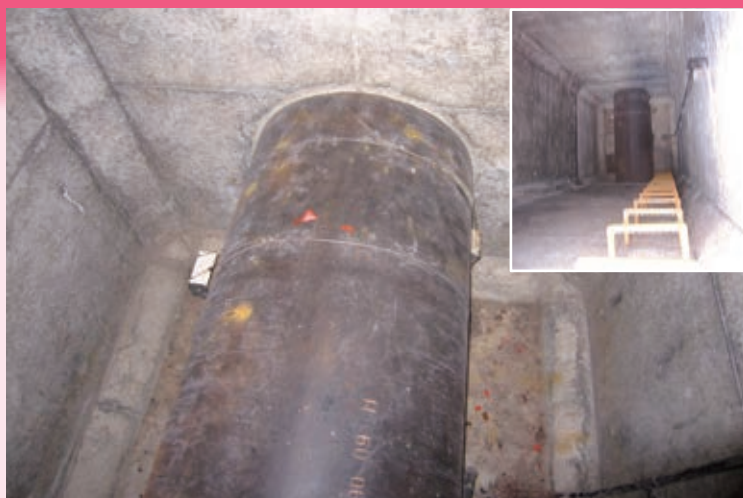
本管に設置されている超音波流量計
