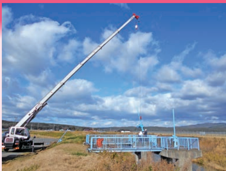
取水ゲート巻上機据付状況
