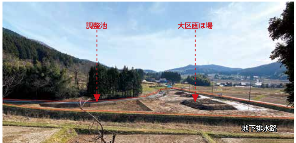
大区画化されたほ場
