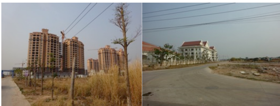
写真 8 新天地内の完成したコンドミニアムと住宅（2016年3月28日撮影）
