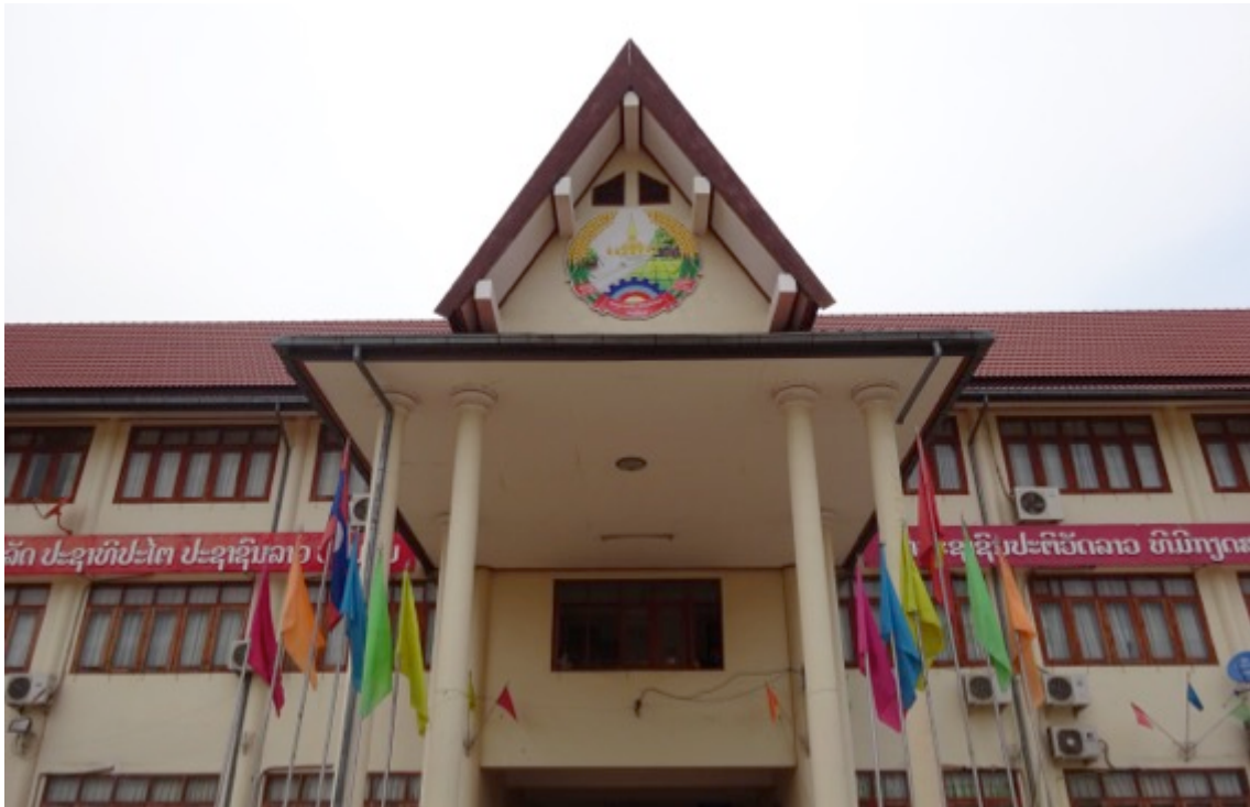
写真 6 スィーコータウン郡の内務局郡事務所
